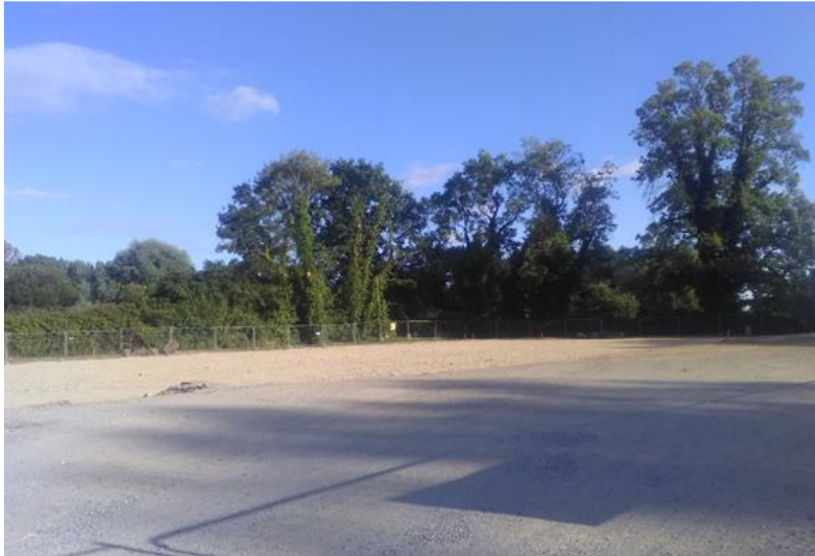
Site après démolition (Septembre 2019)
