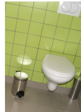
😞 Poubelle trop basse et à pédale, non utilisable pour une personne en fauteuil et qui gêne le recul du fauteuil pour le transfert
