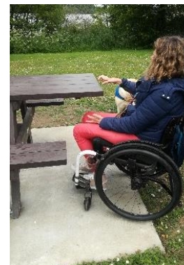
☹ La table est adaptée (extrémité rallongée) mais la plateforme béton n'est pas suffisamment longue pour positionner correctement le fauteuil roulant
