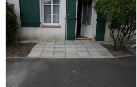
😊 L'accès à cette chambre d'hôtel a été aménagé avec un plan incliné et un palier de repos réglementaires, permettant une bonne circulation
