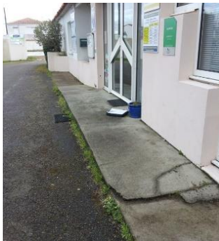
😞 La largeur de ce cheminement trop étroite, combinée à une absence d'espace de débattement de porte et à un ressaut difficile à franchir rend l'accès de cette salle impossible en fauteuil
