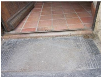
☹ La traverse réduit le passage et le ressaut forme une butée de 5 cm
