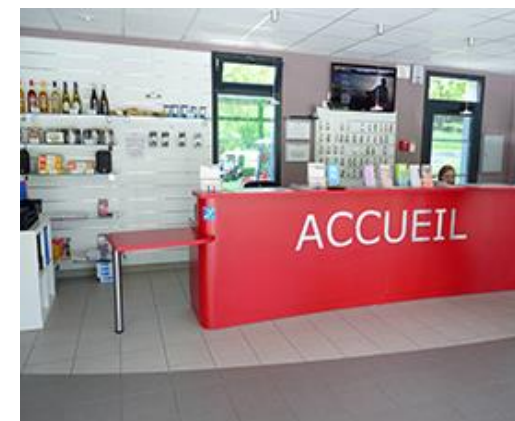
😊 Exemple de comptoir d'accueil avec une partie surbaissée. Attention : l'hôtesse n'est pas positionnée de façon à être vue par une personne en position assis
