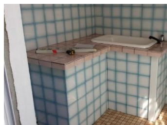
☹ Espace bébé non utilisable par une personne en fauteuil roulant : prévoir un passage pour les jambes à côté de la baignoire
