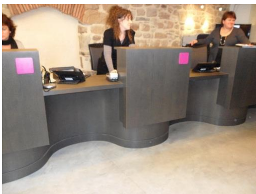
😊 Exemple de comptoir d'accueil adapté. La réglementation accessibilité oblige au minimum un poste d'accueil adapté. Sur cette photo, le prestataire est allé plus loin dans sa démarche d'accueil en proposant des parties surbaissées pour chaque poste d'accueil
