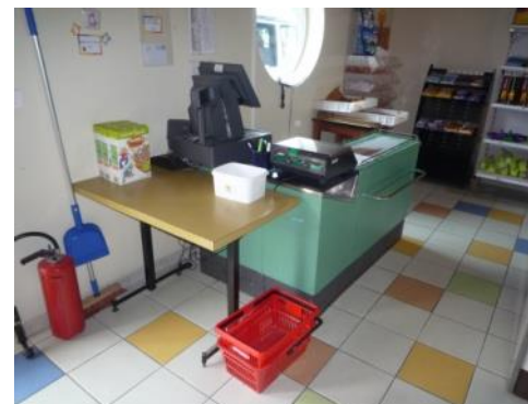
☺ Largeur minimale de passage aux caisses conforme : 90 cm
