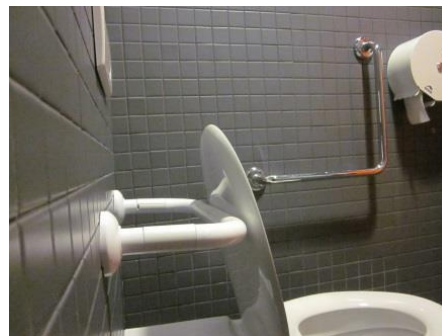
😊 Un dossier a été fixé au mur pour permettre à la personne handicapée moteur de s'appuyer et de rester ainsi assise confortablement
