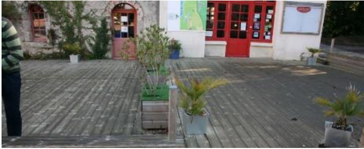
😊 L'accès à ce bâtiment, proposant plusieurs marches, a été facilité par la réalisation d'une terrasse supprimant tous les ressauts au niveau des portes
