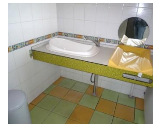
☺ Espace pour le passage des jambes conforme sous la table à langer
